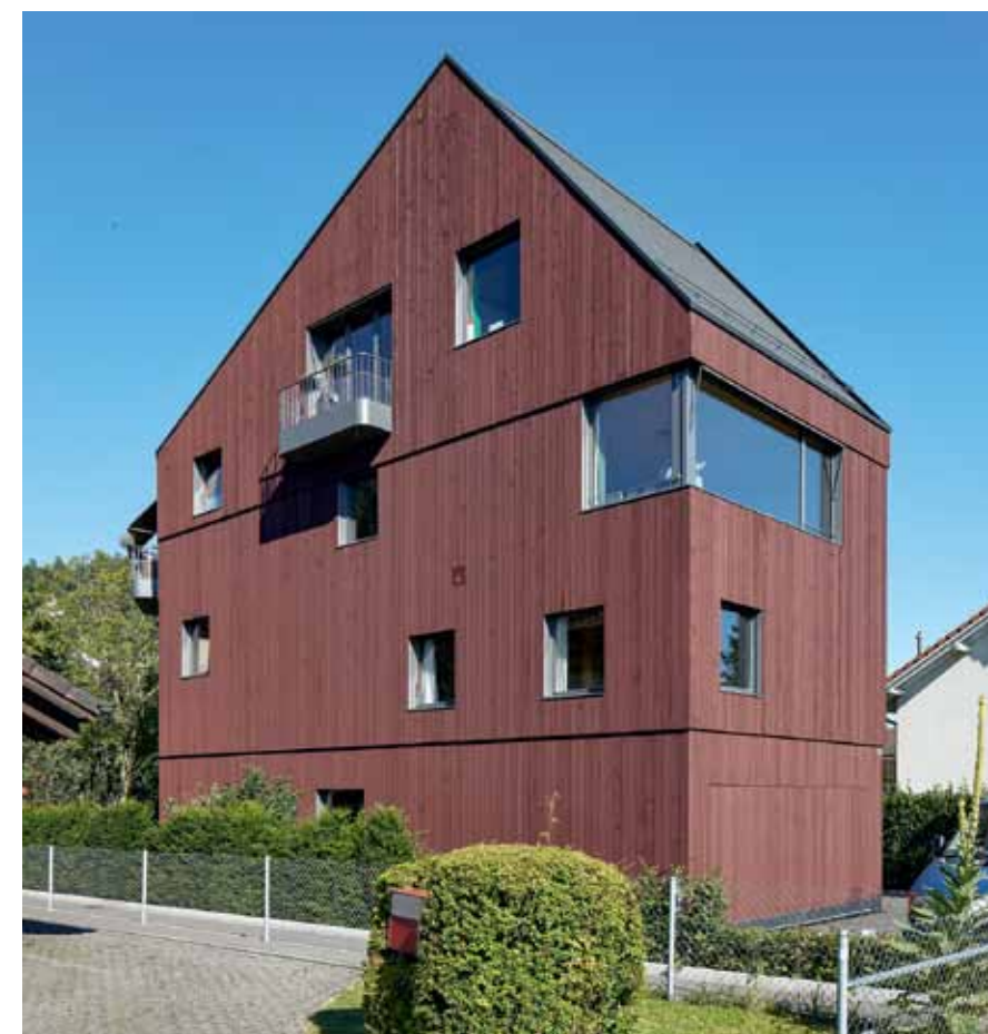
Eingebettet: Die oxsenblutrote Farbe der Fassade aus Weisstanne fällt zwar auf, nimmt aber zugleich subtil auf den dörflichen Kontext Bezug.
