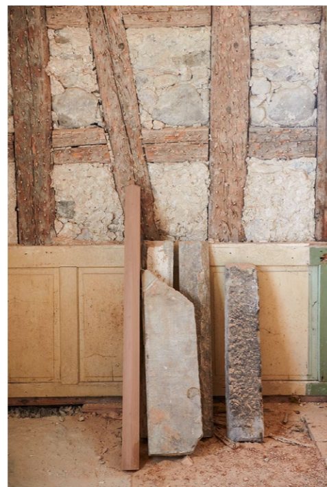
Work in Progress: Teile des Hauses sind noch Baustelle.
