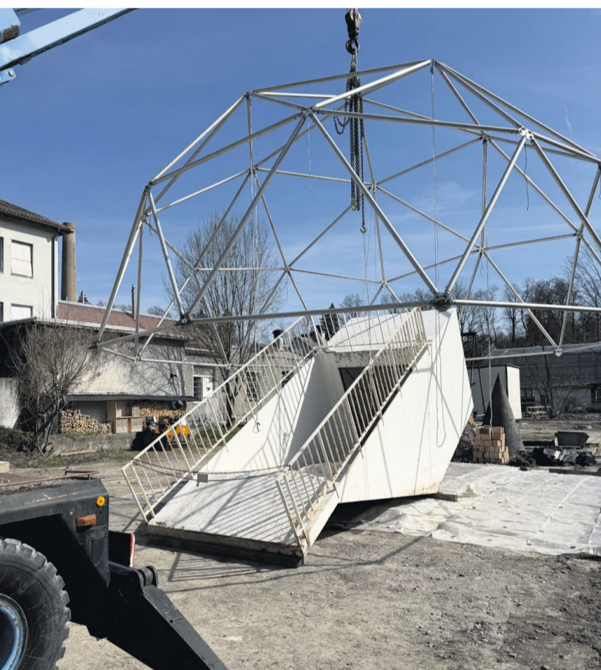
Metro-Eingang von Martin Kippenberger vor der Restaurierung.
